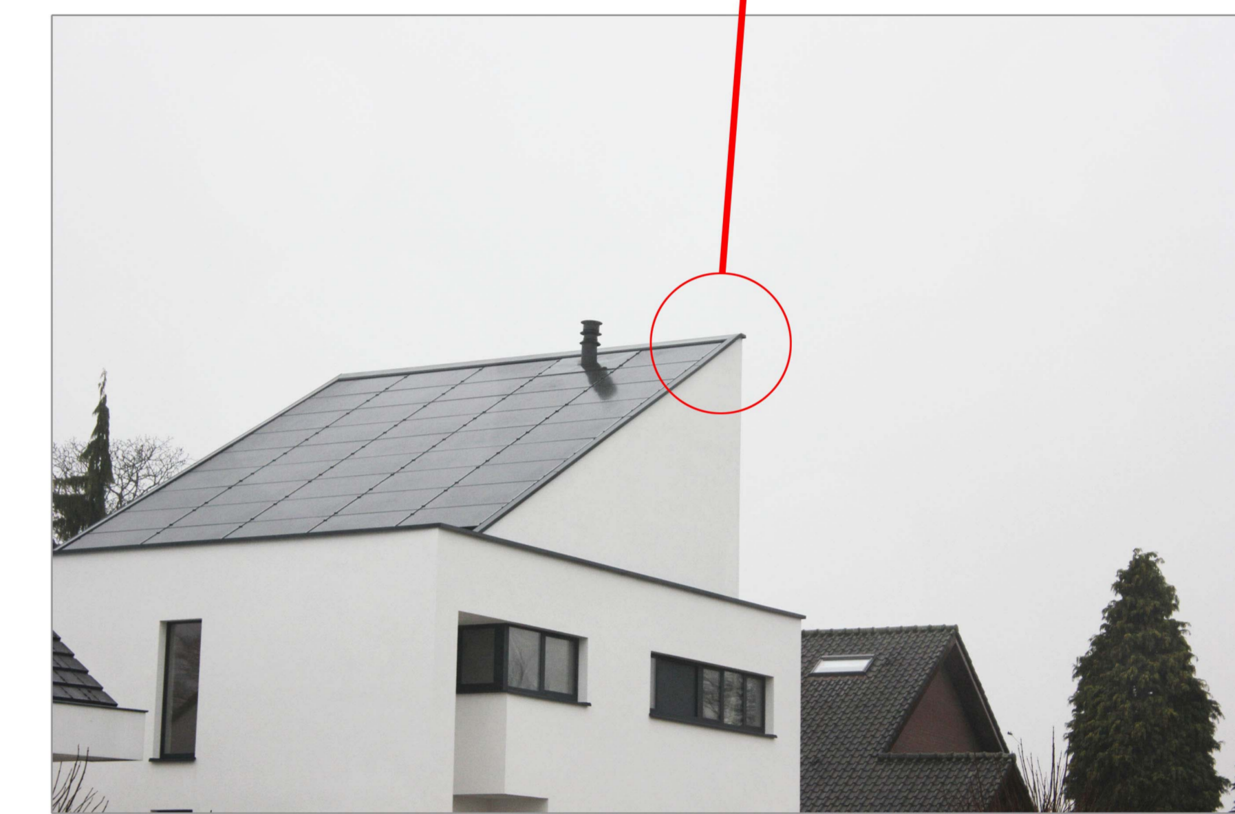
DAKRAND (ZINK) EN ZWARTE ZONNEPANELEN
